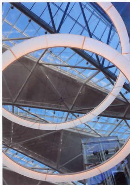
Unsichtbar an einer Tragstruktur aus Aluminium befestigt, schweben die Lichtringe im Raum
