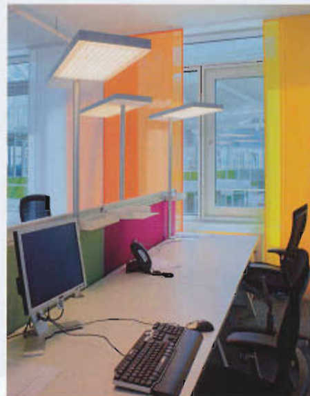
In den Unilever-Büros leuchten 1.400 LED-Arbeitsplatzstehleuchten aus der Serie „Office Air“ von Nimbus. Allein ihr Direktlicht genügt, einen Doppelarbeitsplatz mit 500 Lux auszu-leuchten. So lassen sich rund 70 Prozent der Stromkosten für Beleuchtung einsparen.
