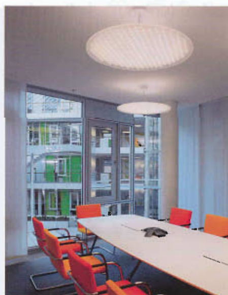
Runde LED-Leuchte in einem Konferenzraum: Von unten zeigen sich die individuell ausgerichteten Kegelsenkungen, in denen die LEDs sitzen. Sie liefern blendfreies, direktes Licht. Im Direktlichtbetrieb benötigen sie 70 W.
