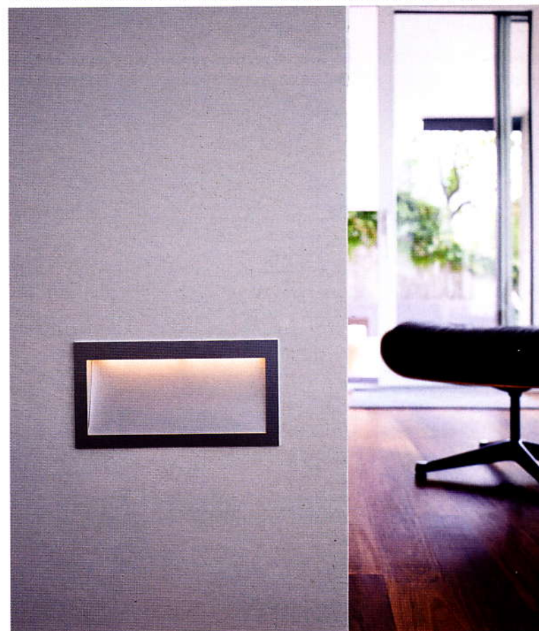
Bodennahe LED-Wandeinbauleuchten sind im ganzen Haus verteilt. | LED wall luminaires near ground level
